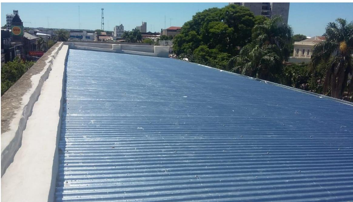
El ingeniero Sergio Gauna relató las obras realizadas en el antiguo edificio de Goya, detallando la renovación total de chapas, clavadoras, canaletas con carga completa y revoque impermeable para evitar el accionar de la humedad. Superando ampliamente la prueba con las últimas lluvias caídas, donde se pudo comprobar el trabajo realizado.
