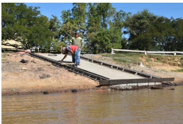
La misma se encuentra ubicada en la Playa el Ingá, con una extensión de 10 m de largo por 3 m de ancho. Construido con hormigón armado con una malla metálica protectora.
