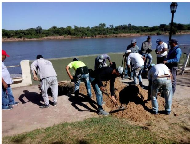
El hueco producido en la vereda, en un sector de Plaza Italia, contra el muro de hormigón, se debe a un socavamiento puntual. El mismo tiene una superficie de 12 m<sup>2</sup> y una profundidad de 4 m. Se procedió a reparación con arena cemento, luego se hará el hormigonado correspondiente.
